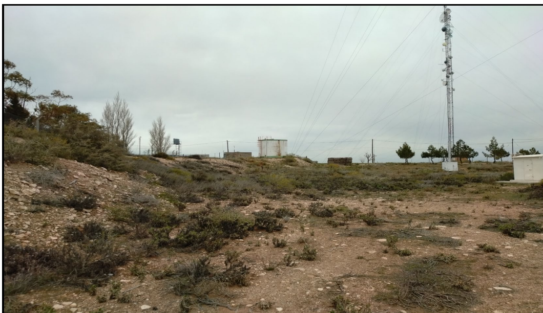
Tanque de agua para riego de la parquización de la casa principal Establecimiento El Estrellero.
