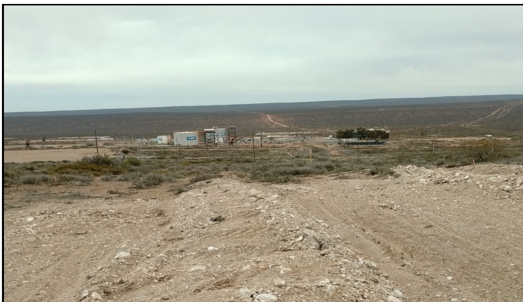
Batería 3 AT, vista desde borde de barda, Flare a 635 mts.
